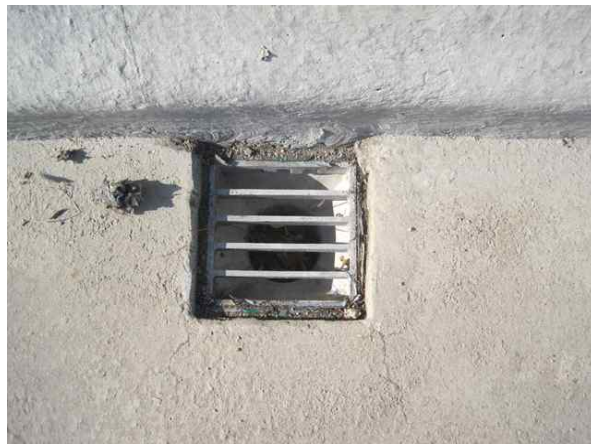
배수시설 상태 양호
