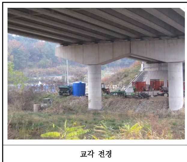
교각 전경 【사진 7.3.10】 교각 전경
