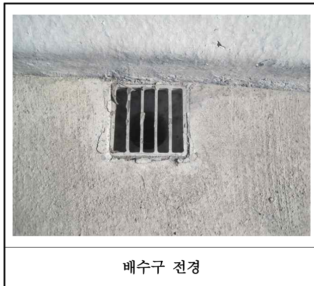
【사진 7.3.21】 배수시설 전경
