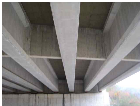
S3 바닥판하면 상태양호
