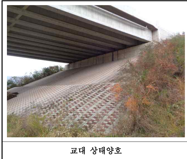
【사진 7.3.9】 교대 손상현황
