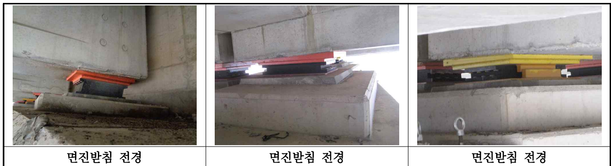
【사진 7.3.12】 교량받침 전경
