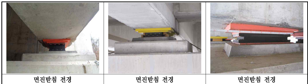
【사진 7.3.12】 교량받침 전경
