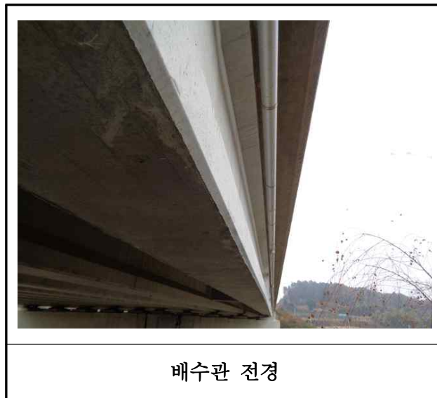
【사진 7.3.21】 배수시설 전경
