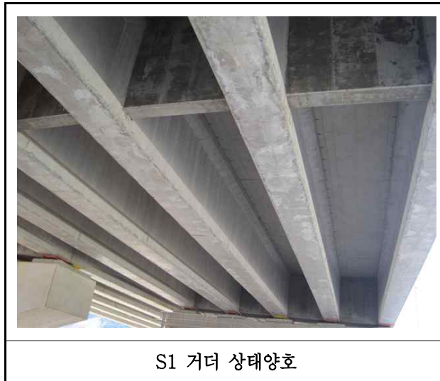
【사진 7.3.5】 거더 손상현황
