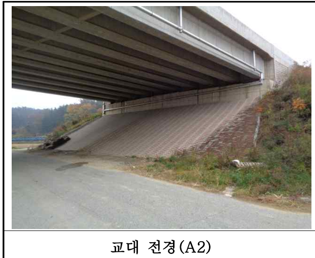
교대 전경 (A2)
