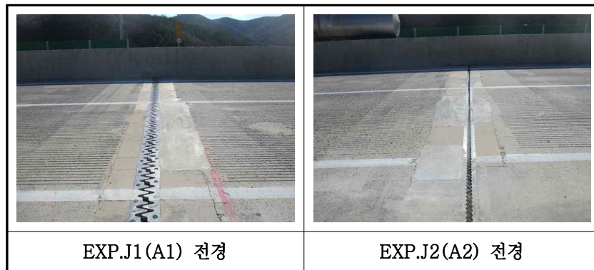
【사진 7.3.16】 신축이음장치 전경
