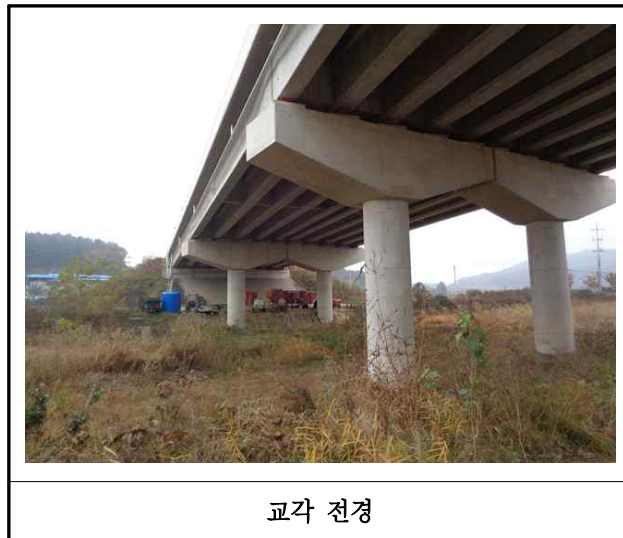
교각 전경 【사진 7.3.10】 교각 전경
