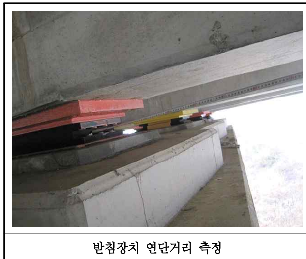
【사진 7.3.14】 교량받침장치 연단거리측정
