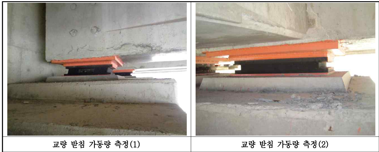
【사진 7.3.15】 교량받침 이동량 측정
