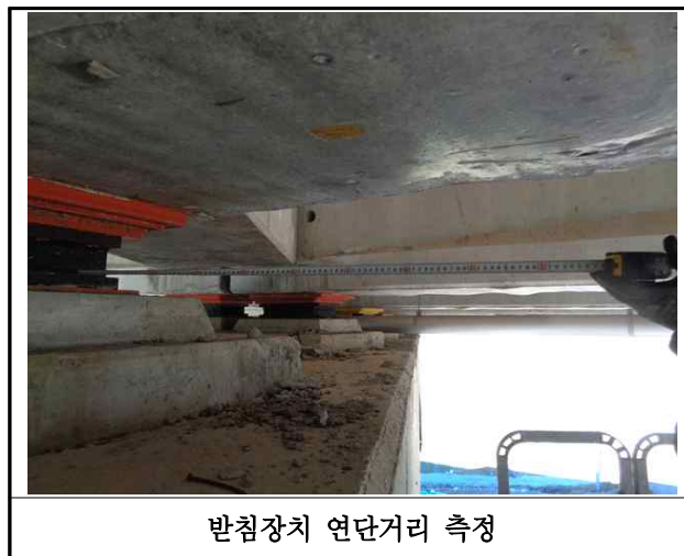
【사진 7.3.14】 교량받침장치 연단거리측정
