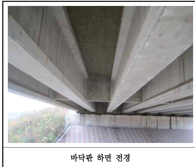
【사진 7.3.2】 바닥판하면 전경
