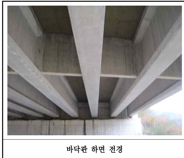
【사진 7.3.2】 바닥판하면 전경
