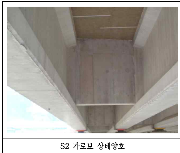
【사진 7.3.7】 가로보 손상현황
