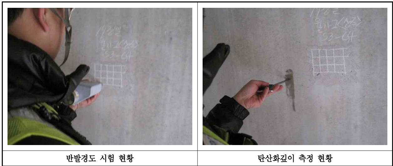
【사진 7.4.1】 콘크리트 내구성조사 현황
