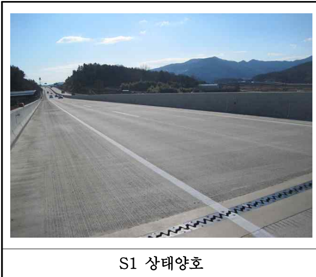
【사진 7.3.20】 교면포장 손상현황
